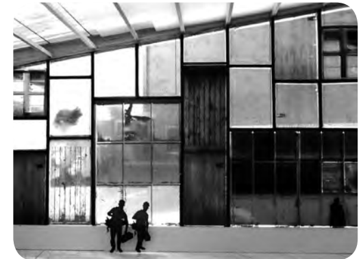
Reemploi Centre / Rebuilt center: façade avec fenêtres récupérées
