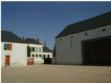
Artenay, architectes Crepet et Cornu.
