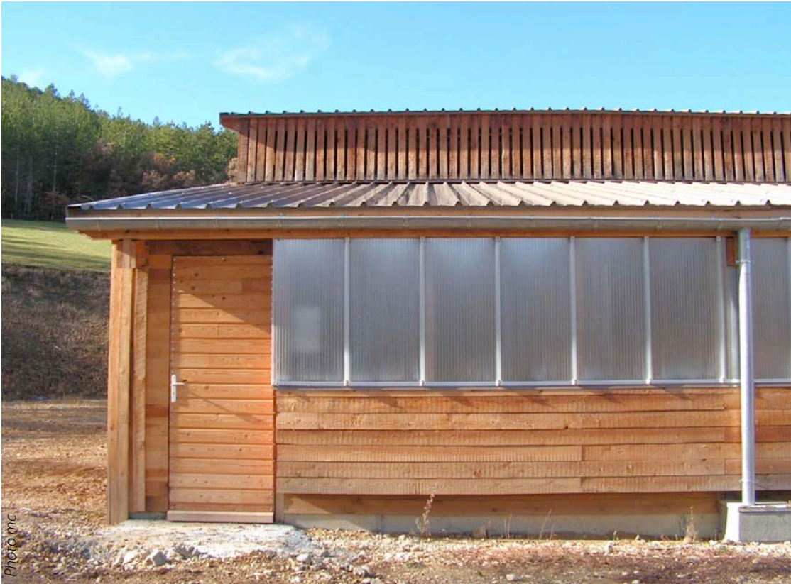
Façade long pan • Traitement de la ventilation naturelle en partie haute avec le bardage ajouré et en partie basse avec un système de double peau régulé par des volets bois.
