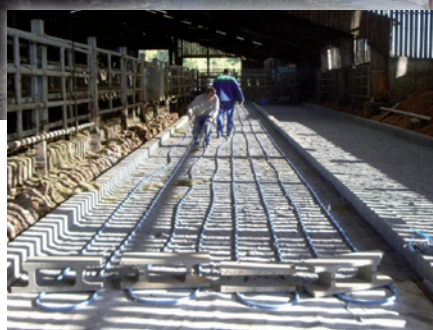
Pose de réseau de capteurs
