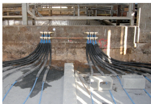
Tête du réseau de capteur sous aires paillées en élevage ruminant
