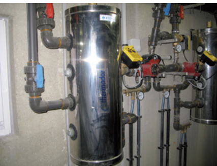
Chauffage par pompe à chaleur
