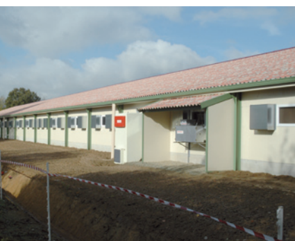
Bâtiment avicole avec récupérateur de chaleur
