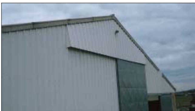
un exemple de cache-rail intégré dans le bardage métallique du pignon
