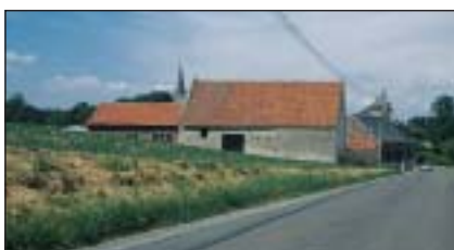
une toiture en tuiles traditionnelles
