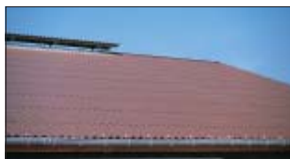
éviter une teinte de matériau qui ne correspond pas à la teinte du matériau imité
