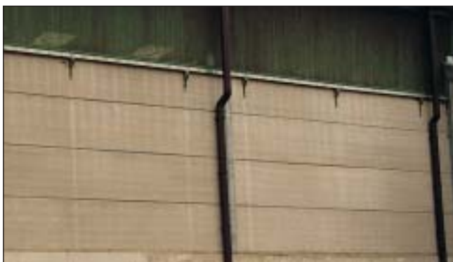
une teinte verte inadaptée aux autres matériaux de la construction
