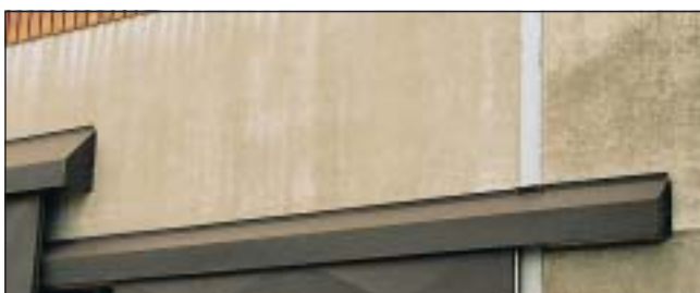
éviter des rails imposants qui découpent plus encore un pignon peu homogène
