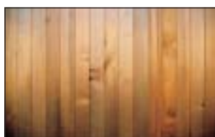
pose à rainure et languette
