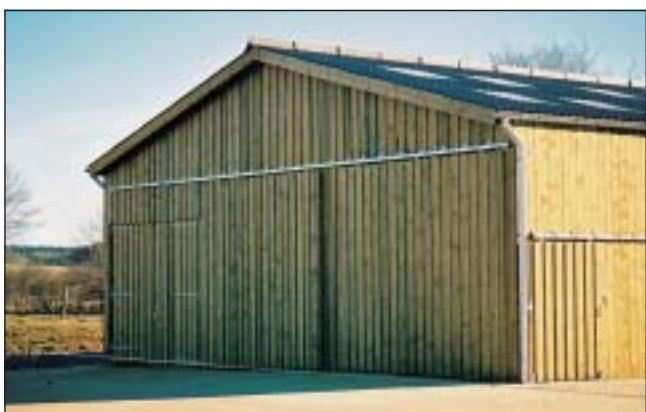
un même matériau pour les portes et les murs
