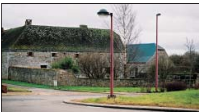
une couverture de toiture trop bleue
