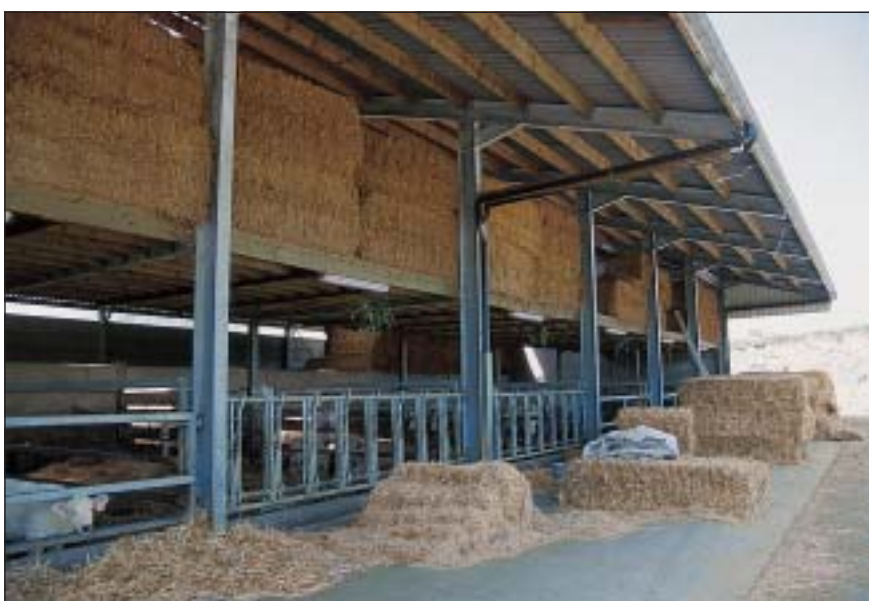
une étable ouverte associée au stockage de la paille en hauteur
