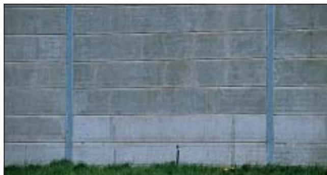
préférer une ossature en acier galvanisé à chaud ou de même teinte que le panneau
