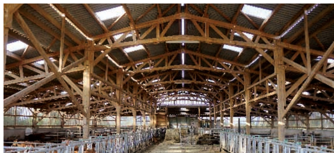
U ne charpente en poutres-treillis
