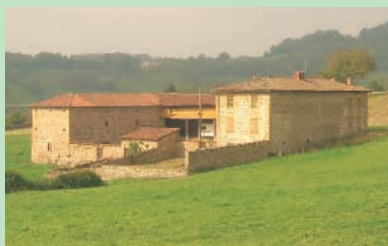
Une ferme construite sur un plan en U à Montrottier
