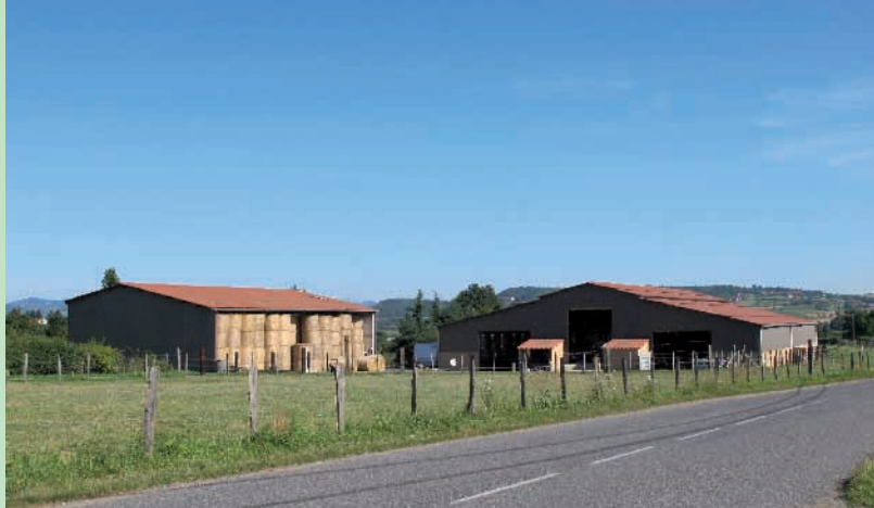
Stabulation et bâtiment de stockage à Fleurieux-sur-l'Arbresle
