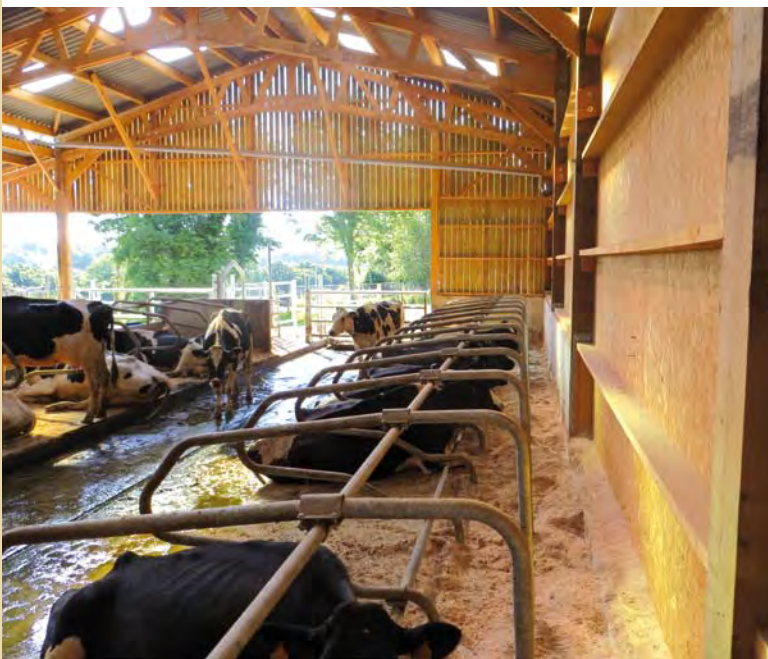
Les maçonneries sont réduites face aux logettes.
