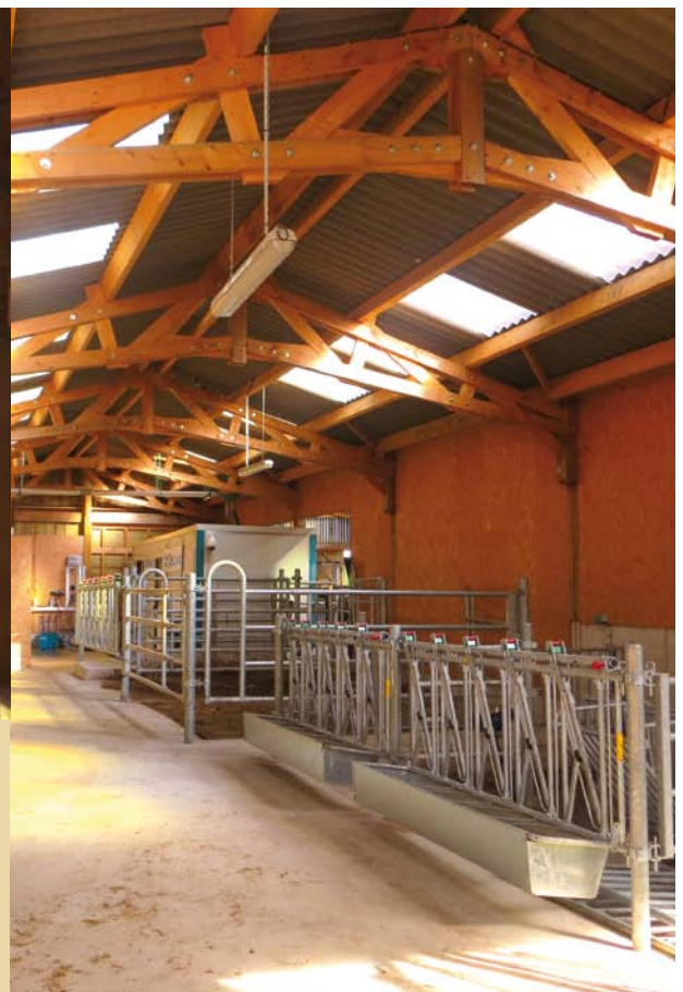
Le bloc traite-nurserie accueille la remorque contenant le robot, les espaces de soin des vaches et le logement des veaux.
