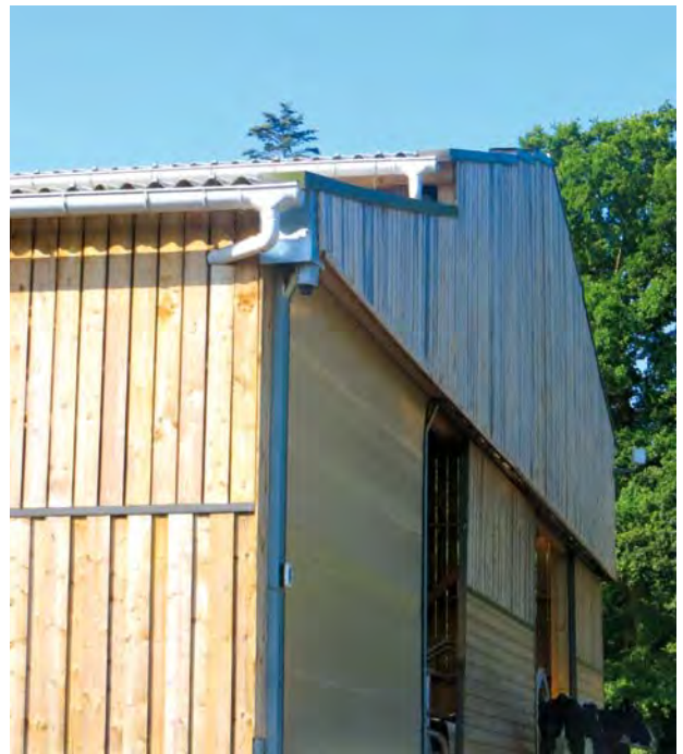
Les finitions des menuiseries et des bardages sont particulièrement soignées
