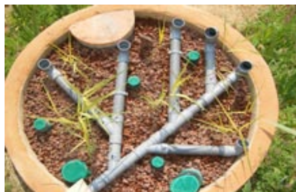
Une araignée de distribution, raccordée à l'arrivée de l'effluent, est posée en surface.
