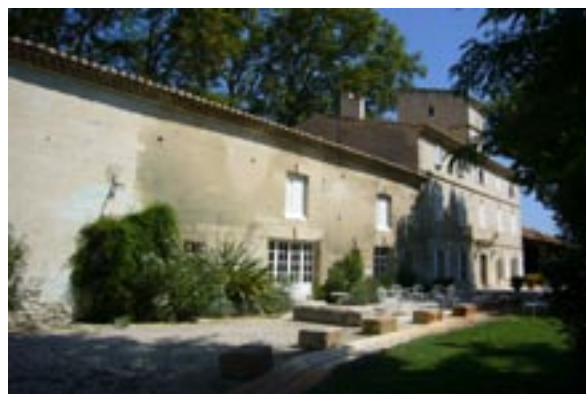
Le Petit Milord : l'habitation se distingue des locaux agricoles par sa hauteur plus importante et la qualité de traitement de sa façade
