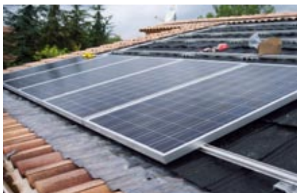
Mise en place de capteurs et de l'étanchéité
