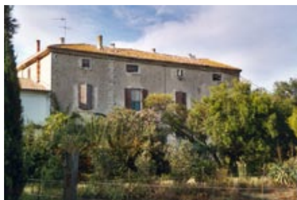
Mas des Iscles : volume imposant à R+1 et attique, façade à 4 travées, toit à 4 versants... distinguent l'habitation des autres bâtiments
