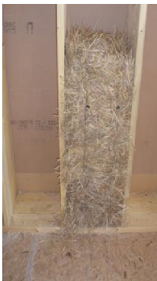
Remplissage d'une ossature bois par des bottes de paille
