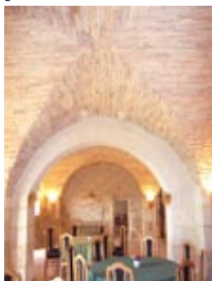
Prieuré St-Pierre de Signan : usage soigné de la brique de terre cuite dans la réalisation de voûtes d'arêtes
