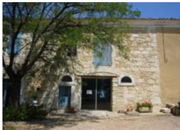
Château de Bellefontaine : si elles se réfèrent aux ouvertures traditionnelles des celliers, les demi-lunes percées sur cette façade n'en respectent cependant pas les axes de composition. Associées au percement malheureux de la porte-fenêtre, elles brouillent la lecture de la façade d'origine.
