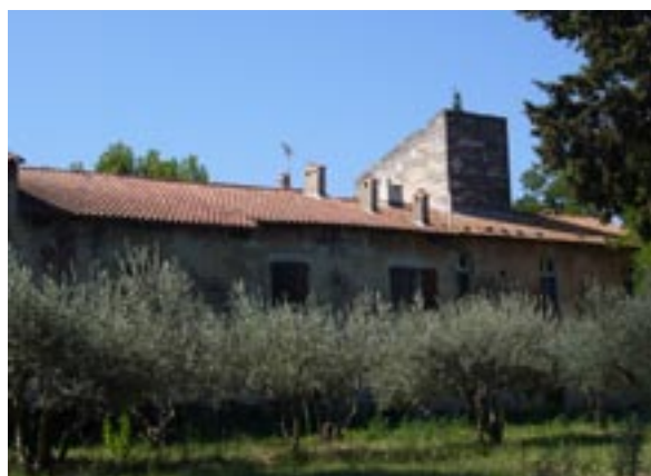
Le Grand Milord : une toiture traditionnelle sans ouverture
