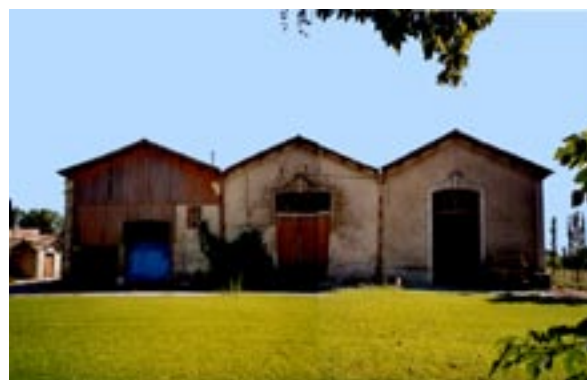
Mas Neuf de Montcalm : façade Nord des chais
