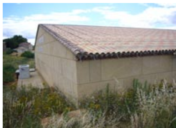
Mas St André d'Olerargues : un exemple de couverture d'une cave réalisée avec des éléments préfabriqués de fibrociment teinté. Seules quelques tuiles rondes de couvert habillent les plaques en rives* ...
