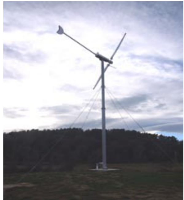
Autre aérogénérateur à axe horizontal à Saint Génès de Malgoires
