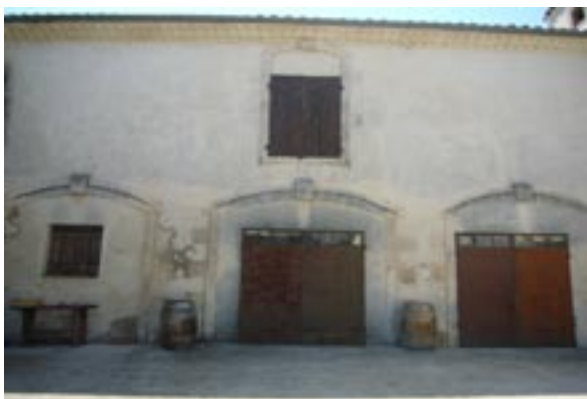
Château Valcombe : une façade qui garde la trace de l'évolution des percements
