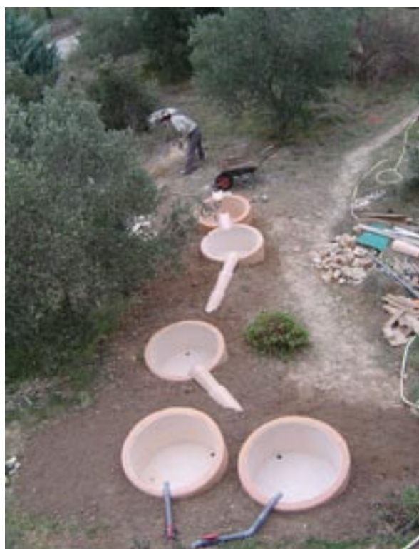
Réalisation de bassins-filtres (Ø:1m) à Saint-Quentin-la-Poterie
