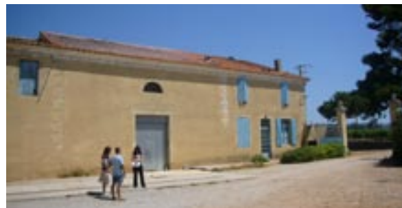
Château Bellefontaine : le logement se distingue des locaux d'exploitation par sa composition symétrique des percements
