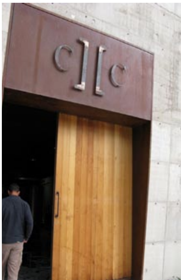
Au chai Altoff, à Sommières, l'acier patinable type Corten s'harmonise avec le bois et le béton brut de décoffrage.
