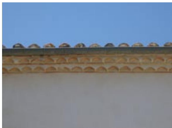
Château Valcombe - Corniche génoise «à deux rangs et filets»
