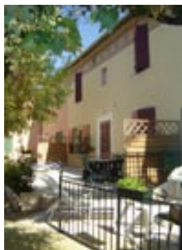
Ancien mas agricole dans le village de Jonquières Saint-Vincent, réaffecté en logements locatifs
