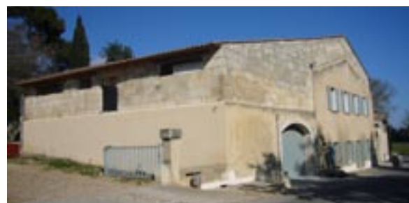
Château Mourgues du Grès : Surélévation pour de nouveaux besoins, adaptation à de nouvelles contraintes d'exploitation
