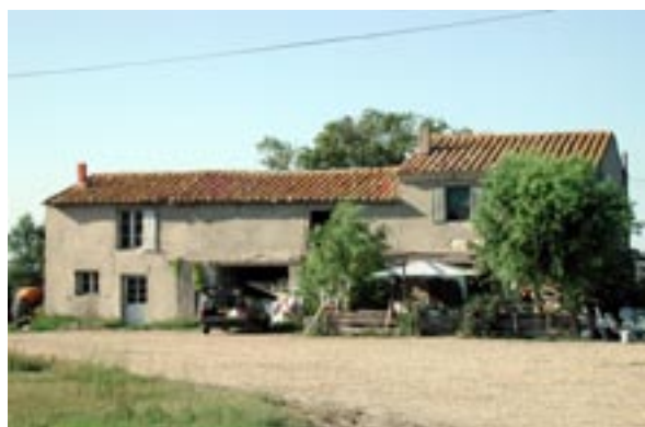
Mas Bramasset : couverture en tuiles traditionnelles, parois en pierre de taille appareillées enduites au mortier de ciment
