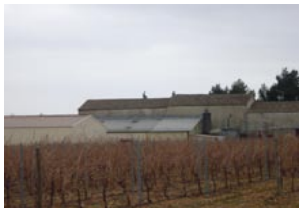
Caveau Virgile : préférer les plaques fibrociment colorée (hangar du 1er plan) à celles non teintées (hangar du second plan), dont la teinte grise du ciment tranche avec celle des tuiles existantes.
