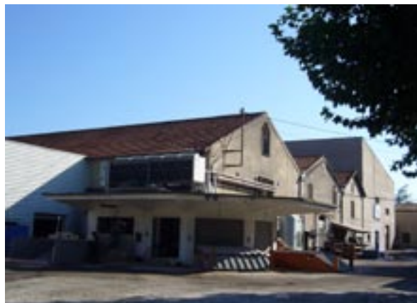
Beaucoup remaniée depuis sa création en 1924, la cave coopérative de Jonquières-Saint-Vincent devrait voir son activité transférée dans de nouveaux bâtiments contemporains, réalisés selon un objectif de qualité environnementale...
