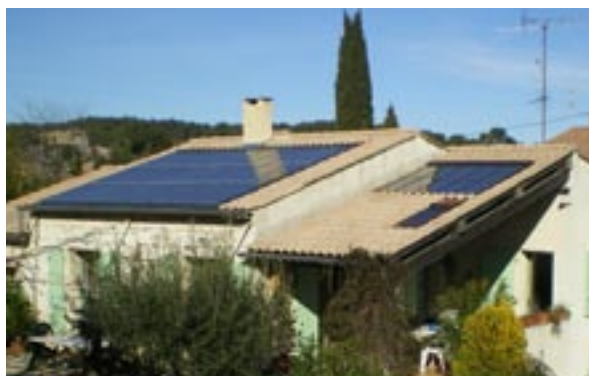
Capteurs thermiques (à droite) et capteurs photovoltaïques (à gauche) dans l'uzège
