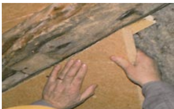
Isolation avec panneaux en fibre de bois
