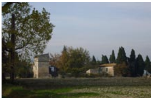
Grand-Milord, pigeonnier réalisé en angle de cour
