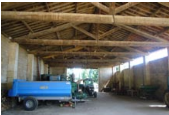
Domaine de Montroch : un hangar aux façades fermées abrite les machines
