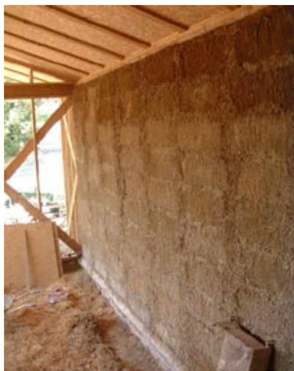
Mur en bottes de paille avant enduit- Chaix viticole dans l'Hérault
