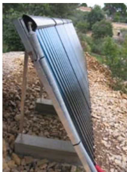
Capteurs sous vide en complément de chauffage
