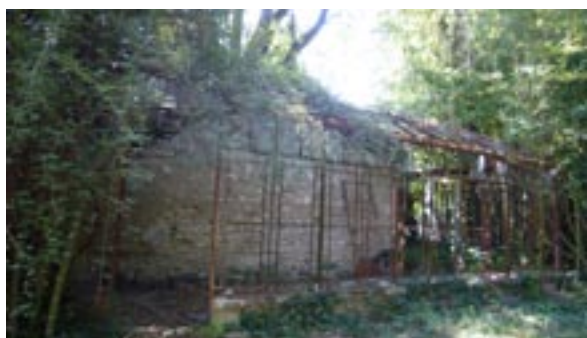
Mas de Fournier : vue sur la structure métallique, seul vestige de la serre
