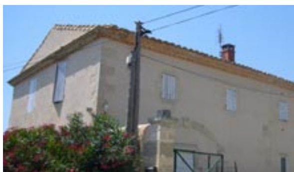
Château Valcombe : utilisation des génoises tournantes* en pignon : une surenchère décorative
