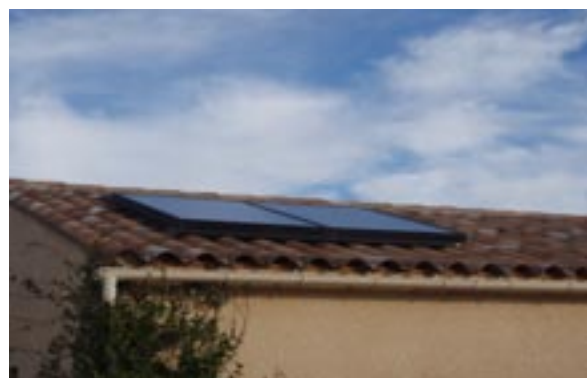
Capteurs en surimposition de toiture (4 m 2 environ de surface de capteurs solaires thermiques pour 200 à 300l d'eau chaude)
