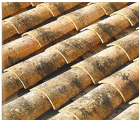
Tuiles canal : couverture traditionnelle de tuiles de dessus et de tuiles de dessous
