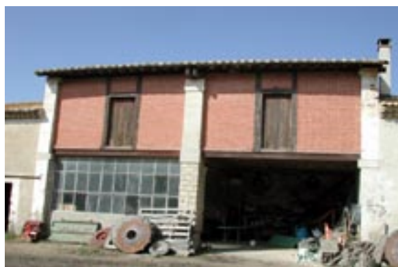
Mas des Iscles : couverture en tuiles romanes, avant toit en bois, maçonnerie en pierre et remplissage en brique
