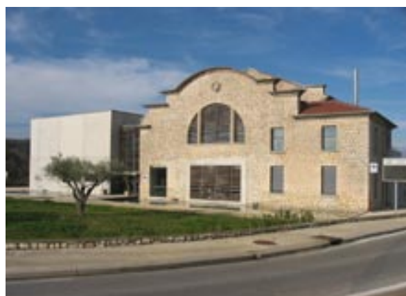
Extension remarquable de l'ancienne cave coopérative d'Allègre Les Fu-mades en Maison de l'Eau, complexe municipal et culturel
