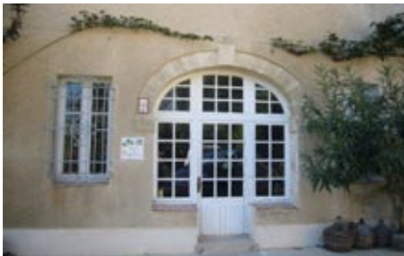
Château Mourgues du Grès : un exemple réussi de transformation de baie conçue à l'origine pour desservir un local d'activité agricole : le percement a été respecté, la menuiserie occupe la totalité du vide. Seul, le nombre des petits bois aurait pu être réduit de sorte que les vitrages aient une forme rectangulaire plus marquée...
