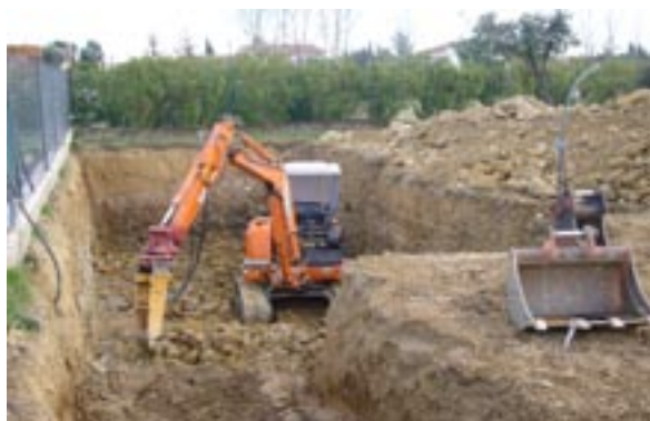
Chantier d'une citerne destinée à la récupération des eaux de toitures de hangars à Saint-Génès de Malgoires
