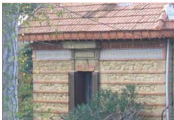
Remoulins : les lambrequins teintés reprennent la couleur de la couverture de tuiles mécaniques
