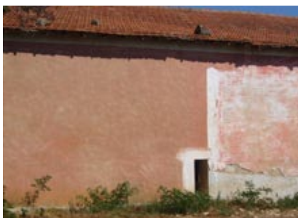
Château Beaubois : finition rouge des façades de la cave, encadrement de baies et couronnement des parois badigeonné de blanc.
