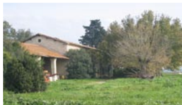
Mas Saint-Jean : toitures à deux versants, couvertures de terre cuite
