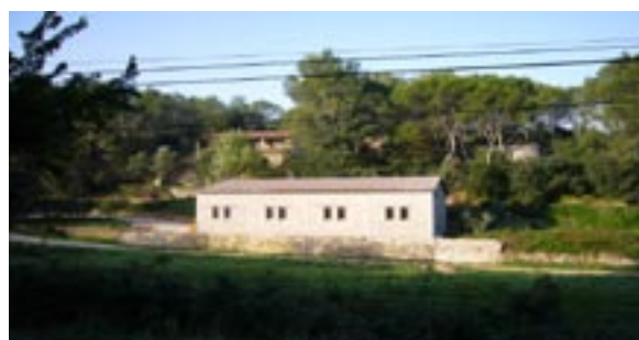
Petit hangar en cours de construction à Sagriès : un bâtiment en longueur bien implanté avec une ligne de faîtage parallèle aux courbes de niveaux
