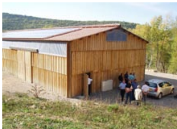
Hangar en bois intégrant des panneaux solaires
