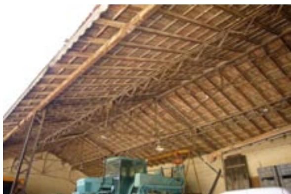
Château Bellefontaine : charpente métallique et tuile romane plate, typiques de l'évolution des techniques de construction et de l'usage de nouveaux matériaux au XIX ème siècle
