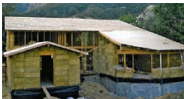
Construction d'une maison à ossature bois et bottes de paille
