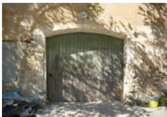
Château Beauvois : portail traditionnel en bois à lattes larges verticales
