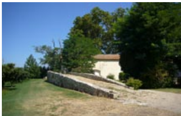
Le Petit Milord : rampe constituée d'un remblai entre deux murs de soutènement
