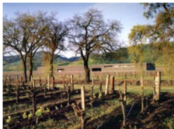
Winery Dominus - Californie : un savant empilement de gabions en pierres de basalte prélevées à proximité du domaine ont permis la remarquable réalisation d'un chai à moindre coût.
