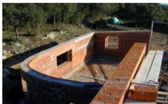
Réalisation en brique de terre cuite alvéolée
