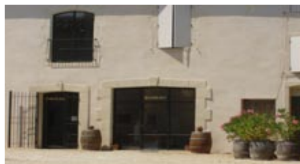
Château de Valcombe - Générac : une information lisible et accueillante
