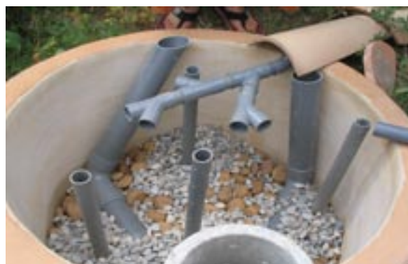
Des drains de fond (Ø : 100 mm) reliés à la surface par des tubes PVC et des tubes verticaux d'aération percés (Ø : 50 mm), sont insérés au moment où l'on place la couche de galets de fond.
