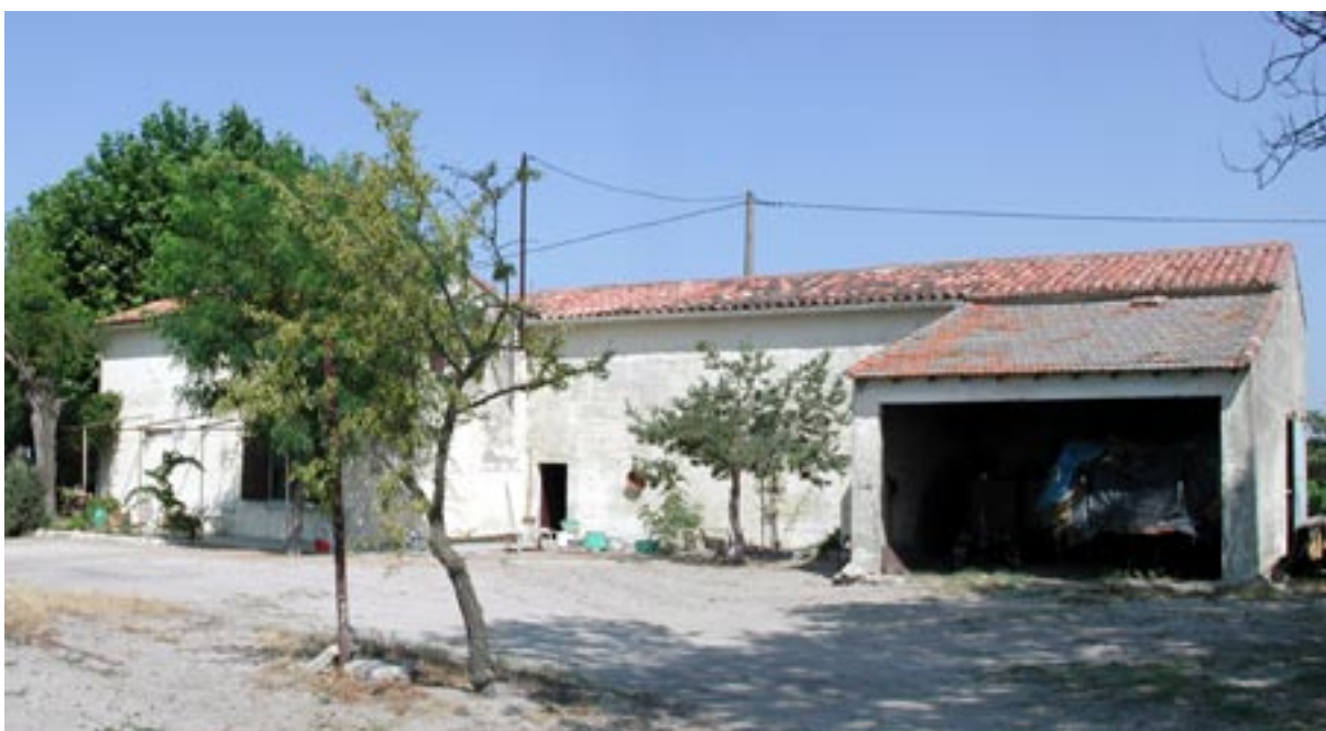
Mas Bleu : juxtaposition de tuiles rondes (ancienne cave) et de tuiles plates mécaniques (apprentis)
