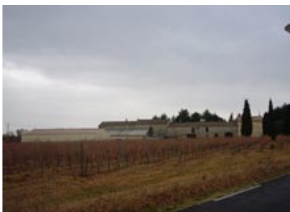
Caveau Virgile, Gallician : la bonne implantation et la volumétrie des extensions, en harmonie avec l'existant, font d'autant plus regretter les choix malheureux des matériaux de couverture...
