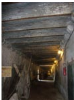
Le Petit Milord : rampe constituée d'un remblai entre deux murs de soutènement
