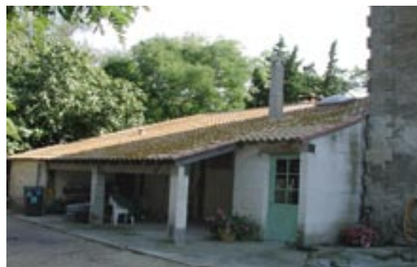
Mas des Iscles : ici, les ouvertures, réalisées en léger retrait intérieur des piliers respectent une lecture de la structure et des éléments qui la composent
