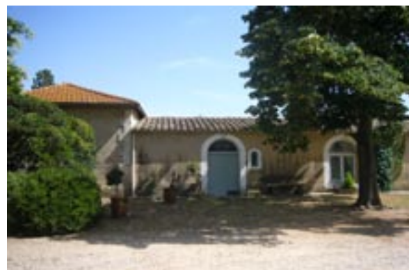
Montroch - Ouvertures en plein cintre
