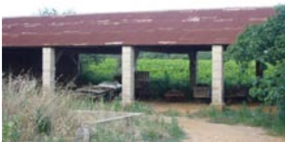
Mas du Chêne : dépôts divers et machines agricoles intégrés sous un hangar à l'arrière des bâtiments
