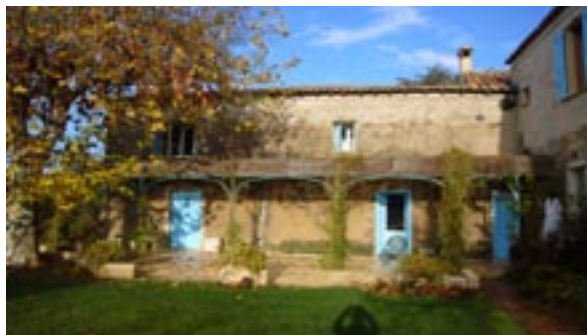
Prieuré St-Pierre : pergola métallique végétalisée traditionnelle
