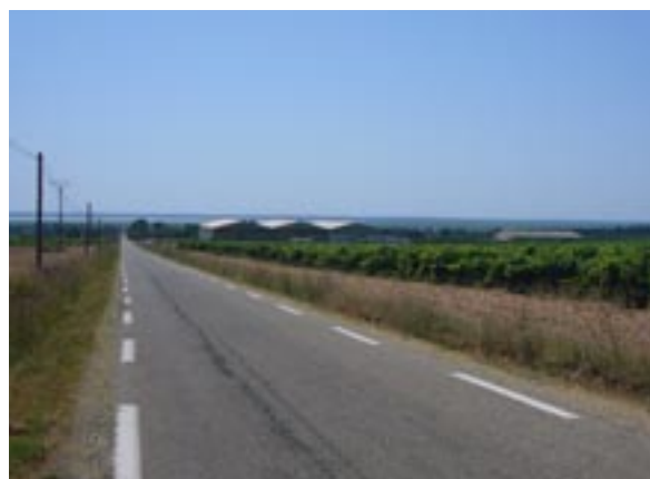
Hangars (à gauche) mal implantés (lignes de toits perpendiculaires aux courbes de niveau et à la ligne d'horizon) brouillant le paysage, contrairement au bangar voisin bien orienté (à droite)
