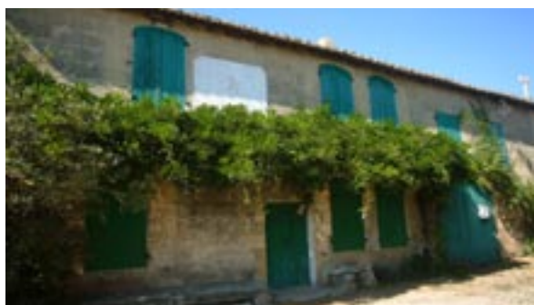
Mas Rabot : la treille protège la façade sud des rayons solaires
