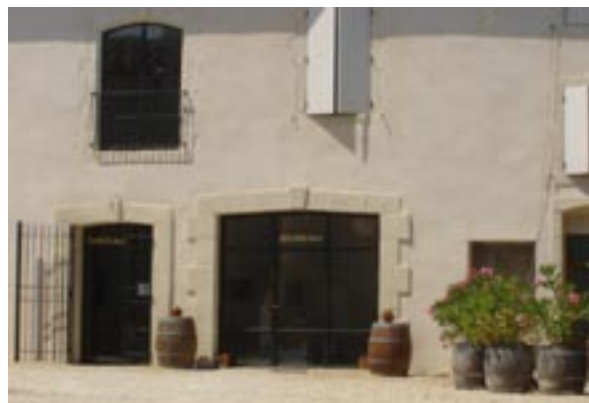
Château de Valcombe : cohabitation réussie de menuiseries métalliques et de menuiseries bois
