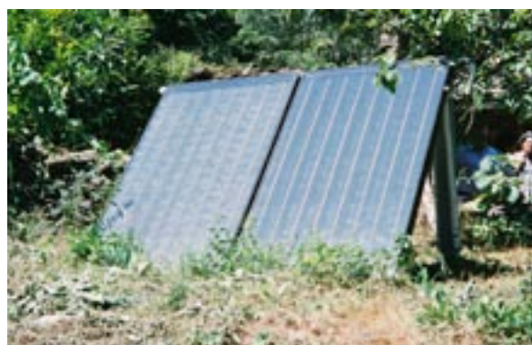
Capteurs plans en complément de chauffage
