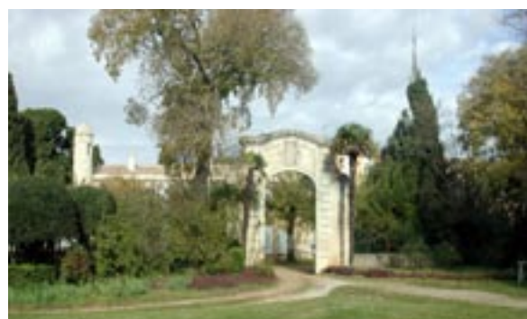
Château de Beck : porte monumentale de la maison de maître. En façade sud, présence d'une tourelle en encorbellement
