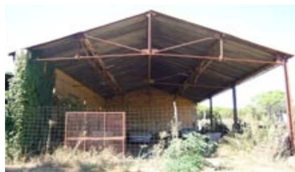
Mas Beauvois : charpente métallique industrielle du XIX e siècle
