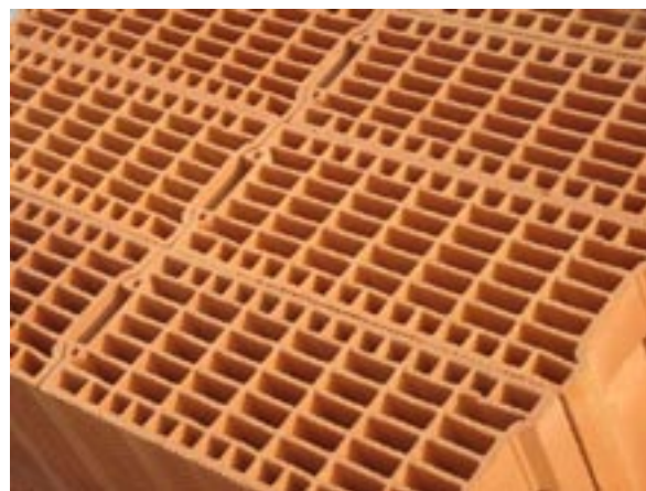
Brique de terre cuite alvéolaire
