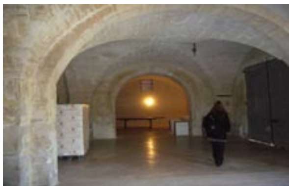
Château Mourgues du Grès : emploi de voûtes d'arêtes en pierre
