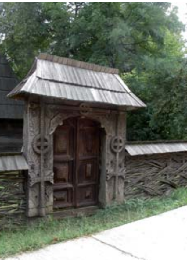
Porte en bois, Maramures, Nord de la Roumanie
