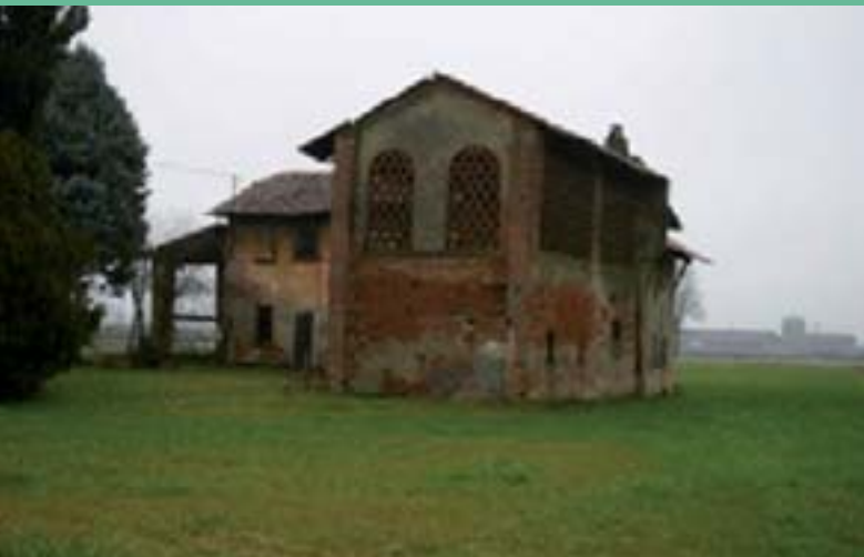
Ruines d'une vieille « cascina », près de Lodi
