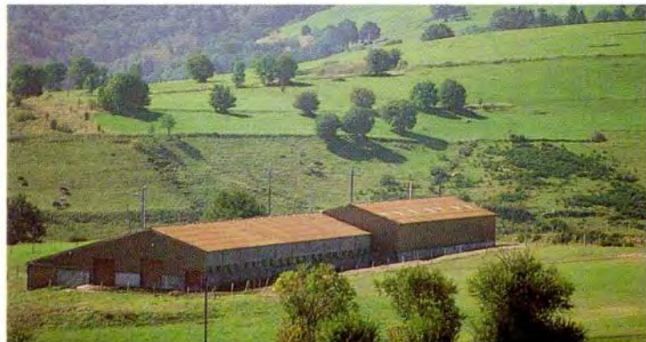
Bâtiment après traitement.
