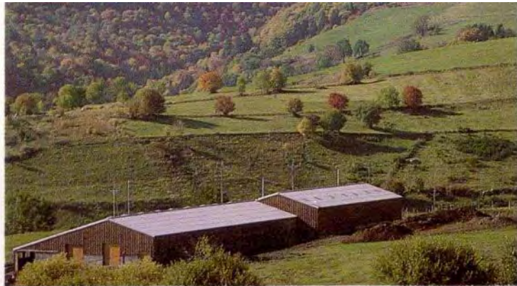
Puy-de-Dôme - Bâtiment avant traitement.
